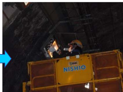
▲点灯しないトンネル内の照明灯を交換します。
