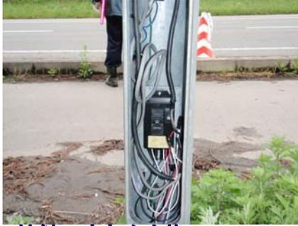
▲照明灯のポールの中。接触不良部を交換。
