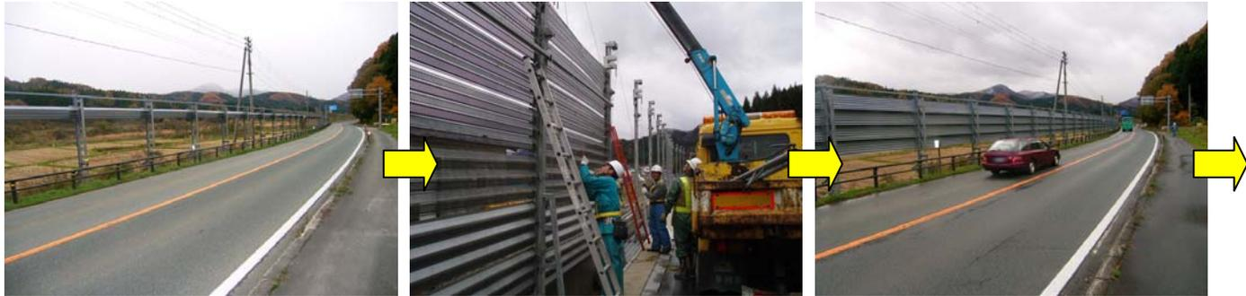
▲地吹雪による視界不良を防ぐ防雪柵。夏の間たたんでいたのをひろげて設置します。
