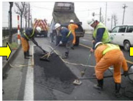
▲冬の舗装工事は品質確保的に難しくなるため、冬期前に本格的な路面補修を完了します。
