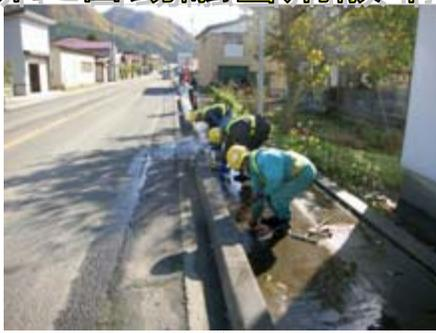
▲歩道と車道の消雪パイプの試験稼働チェック。16時～18時を除く時間帯に水分感知と温度感知で稼働します。
