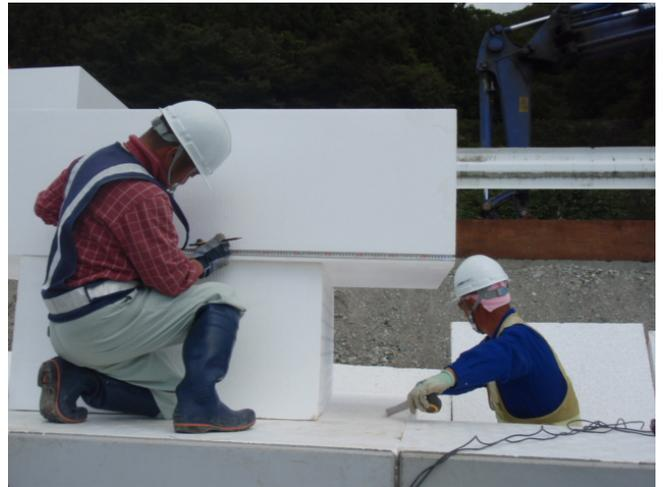
△正確に寸法を測って切断します
