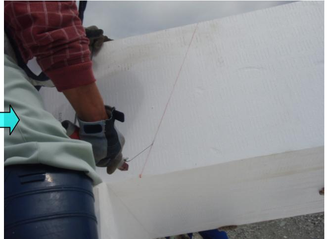
△針金に熱を通して切断します
