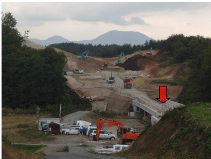
▲矢印の橋の高さが高速道路の高さになります。これからもっと山側の掘削が進みます。
