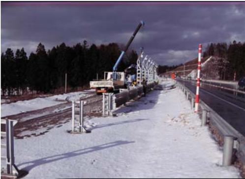
上部支柱を建て込み、支柱間に折りたたまれた防雪板をセットしていきます。
