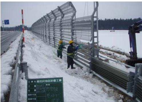
専用器具を用いて、折りたたまれた防雪板を自動立ち上げて、完成です。
