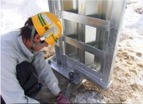
コンクリート基礎に、下部支柱を結合します。
