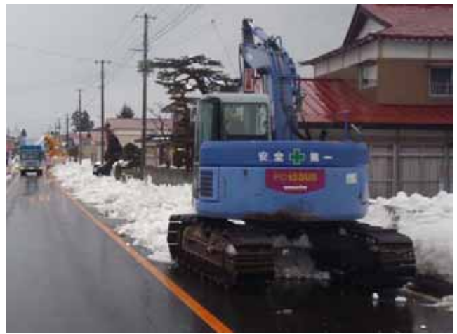
△作業全景。バックホウと人力で雪をかきだし、 ロータリー除雪車でダンプトラックに雪を積み込みます。
