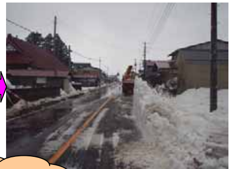
△ローリー除雪車でダンプトラックに積み込みます。
