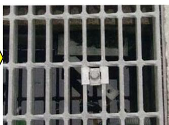
グレーチング蓋(網目状の蓋)に跳ね上がり防止金具がついていないと、車が上を通過した衝撃でグレーチングが跳ね上がり、事故に直結する場合があります。
