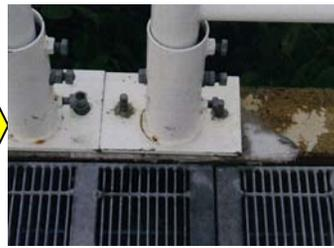
転落防止柵の取付部分が破損していました。
