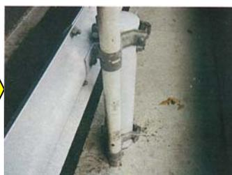
ガードレール支柱が腐食していたので補修しました。
