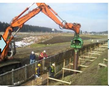
杭をブルブル振動させて、まっすぐ地中に打ち込みます。
