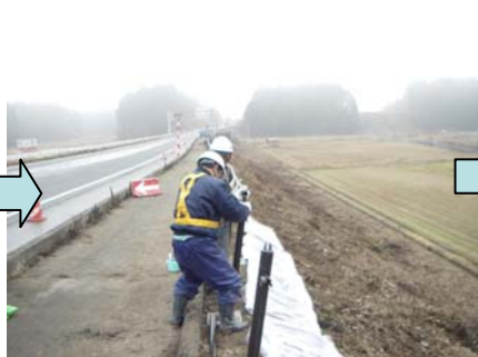
建て込んだ支柱に、柵本体を連結していきます。
