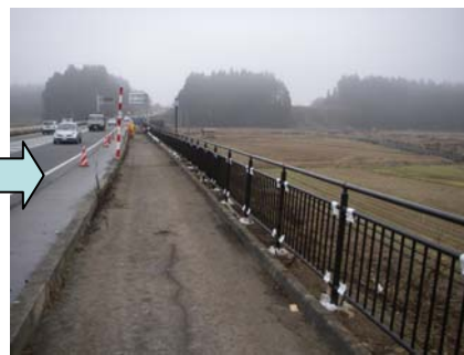
組み立て作業、完了です。
