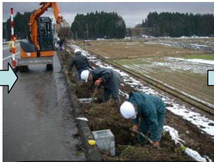
基礎ブロックを設置、穴を戻します。
