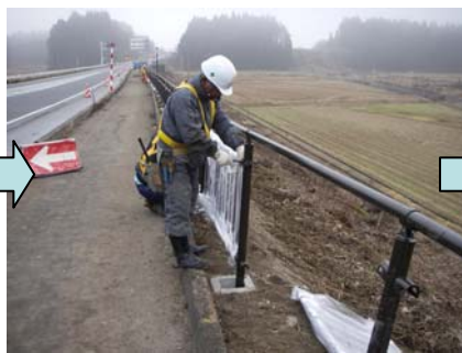
建て込んだ支柱に、柵本体を連結していきます。
