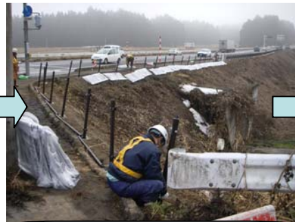
基礎ブロックに支柱を建て込みます。
