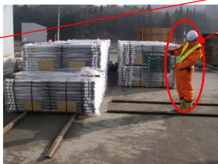
支柱&柵 搬入時の立会い状況
