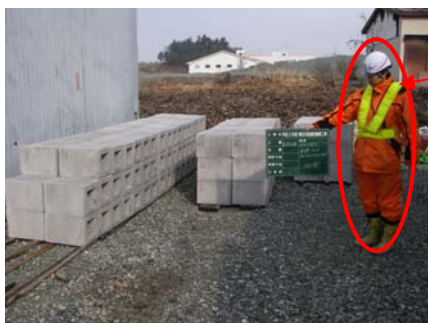
基礎ブロック搬入時の立会い状況
