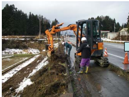
基礎ブロックを設置する穴を掘ります。
