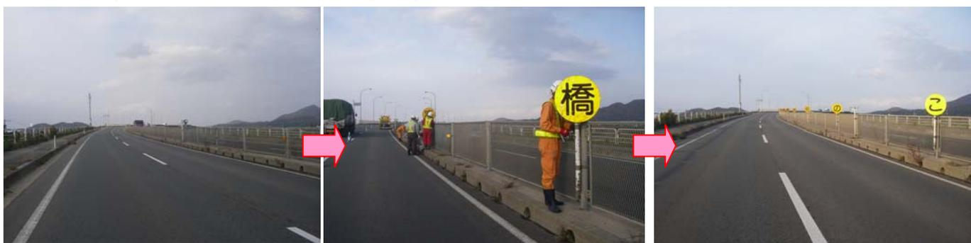
△橋の上は凍結しやすい箇所。注意喚起のポールを設置します。
