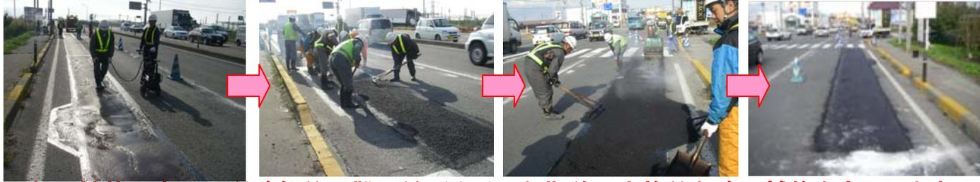
△冬の舗装工事は品質確保的に難しくなるため、冬期前に本格的な路面補修を完了します。
