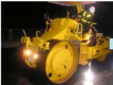
最初に、マカダムローラで締め固め。
