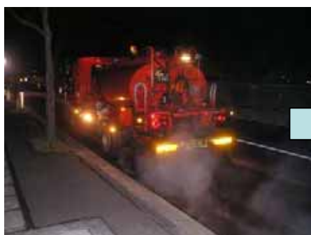
専用機械で、接着剤を散布します。
