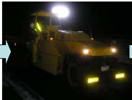
最後に、タイヤローラで締め固め。
