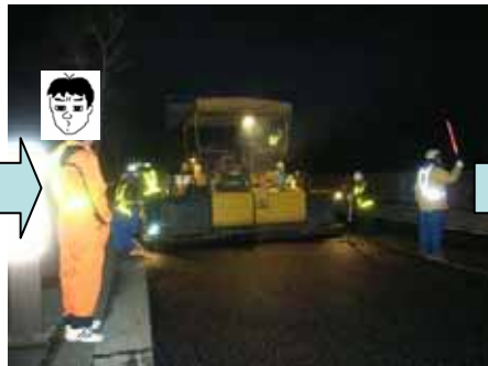
アスファルトフィニッシャー後方からの撮影。フィニッシャーが前進し、舗装が敷きならされています。
