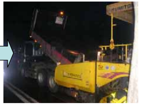
アスファルト合材がフィニッシャーへ。この2台ドッキング状態で、同時に前進しながら舗装工事の開始です。
