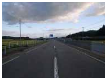
▲ 着手前:全景(箇所②)
