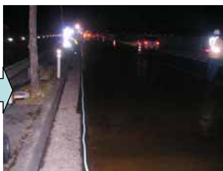
道路端には排水パイプがセットされます。
