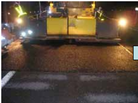
アスファルトフィニッシャー後方からの撮影。フィニッシャーが前進し、舗装が敷きならされています。
