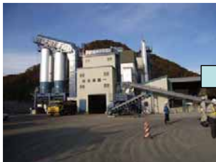
アスファルトプラント(製造工場)で確認します。
