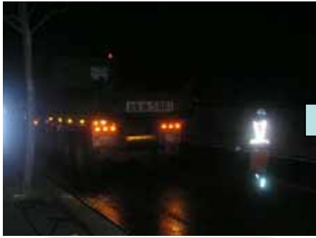
アスファルト合材を積んだダンプトラックが到着。
