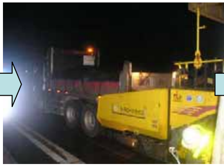
アスファルトフィニッシャーの受け口とドッキング～。
