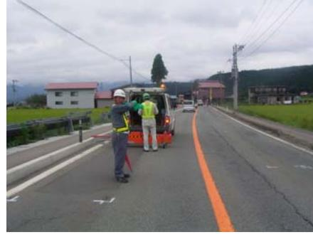
専用器具で正確な測量調査を実施。舗装表面の損傷状況を、把握しておきます。(この予備調査が、切削後に活かされます。)
