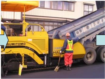
専用機械【アスファルトフィニッシャー】を使用します。
