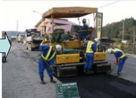
その日のうちに、舗装を急復旧します。(交通量の多い国道では、交通安全上の観点から、車が安全に走れる状態に戻してから、交通規制を解除します。)
