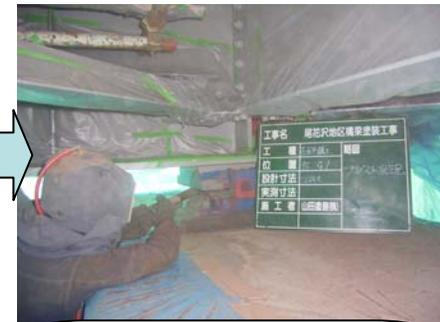
専用機械でガーネット粉体を吹き付け、支承を完全に丸裸にします。
