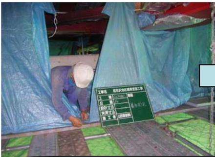
作業時に発生する粉じんが飛散しないよう、シートで覆います。
