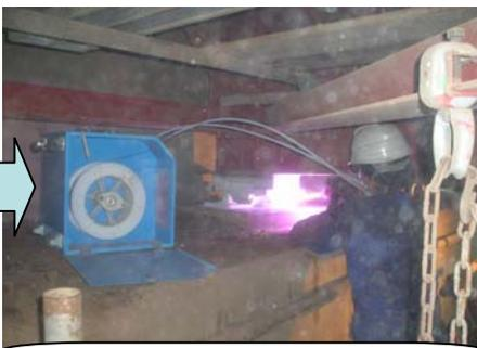
亜鉛アルミ合金線が溶射されます。
