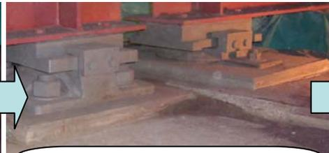
ブラスト作業で、古い塗装膜とサビを完全にに取り除き、丸裸状態にしたら・・・
