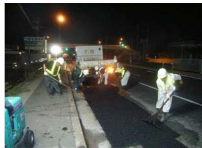
一冬越えて雪解け後の4月～5月は、舗装がポロポロ。パンクなどの事故防止のためにも補修が不可欠です。
