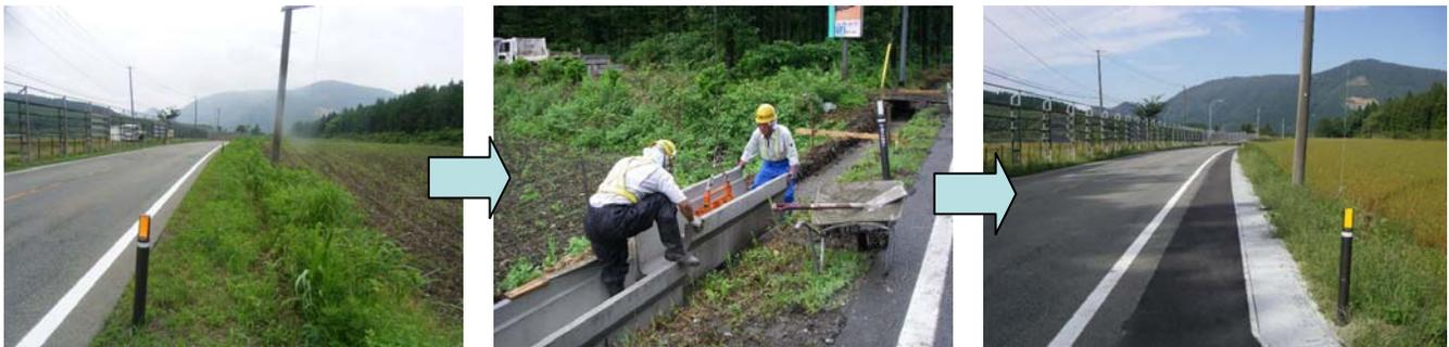
特に冬の交通安全確保のため、計画的に狭い路肩を拡幅し、あわせて堆雪帯(雪を寄せてためる箇所)確保を図ります。
