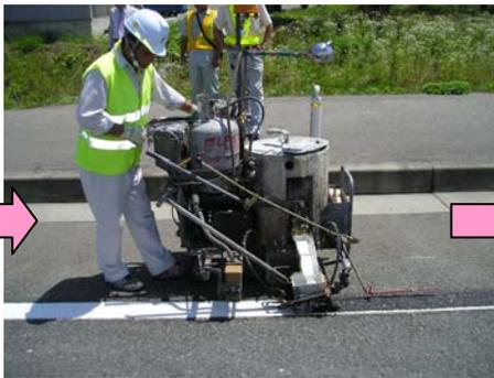
路面の溝に沿って、白線塗料を引きます。
