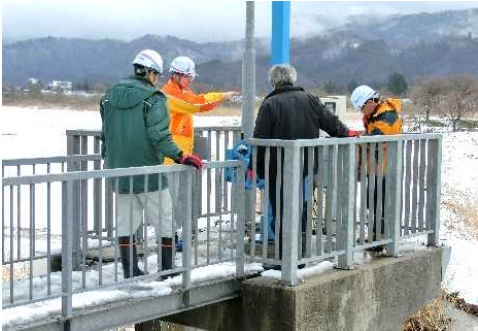
高玉排水樋管
