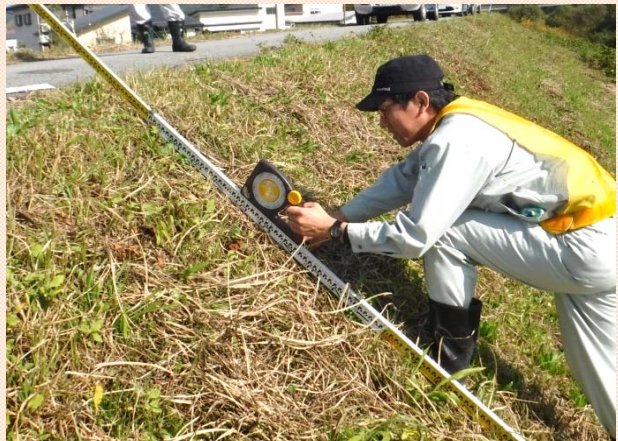
傾斜角度を測定中(堤防の形状確認)
