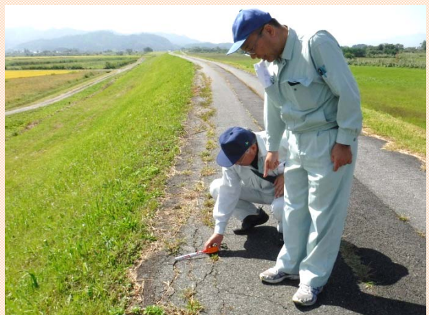
堤防天端の状態を確認・雨水の浸透がないか点検
