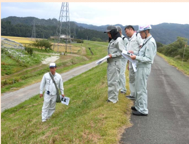
法面の植生状況点検中
