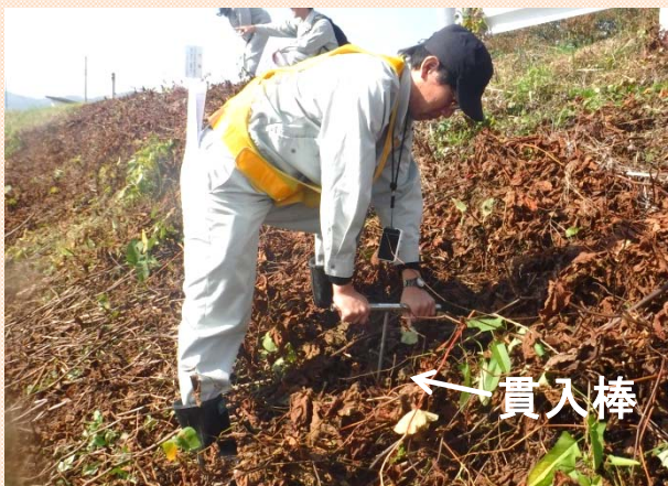
貫入棒を挿入して堤防の強度を測定中
