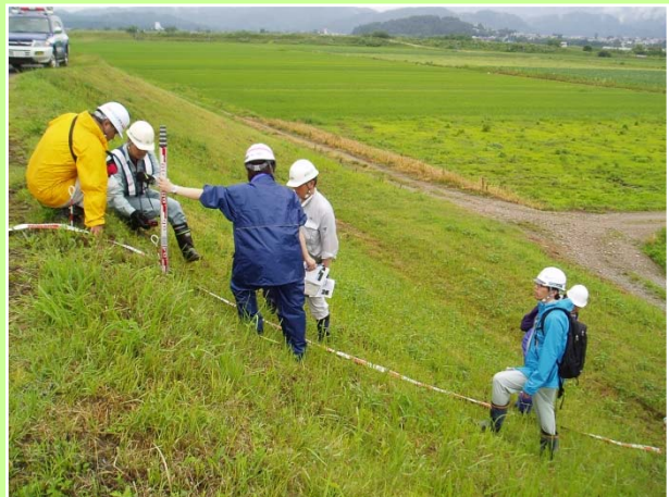
堤防天端の状態を確認、雨水の浸透びり点検
