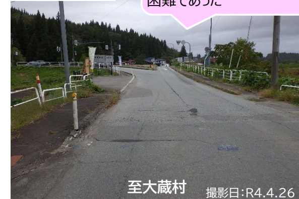
写真②対策後(グルーピング舗装施工)
