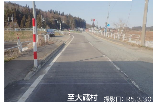
写真②対策後(グルーピング舗装施工)
