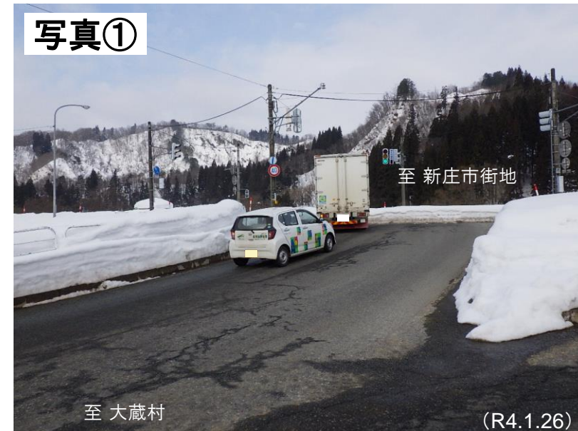
現場状況写真
