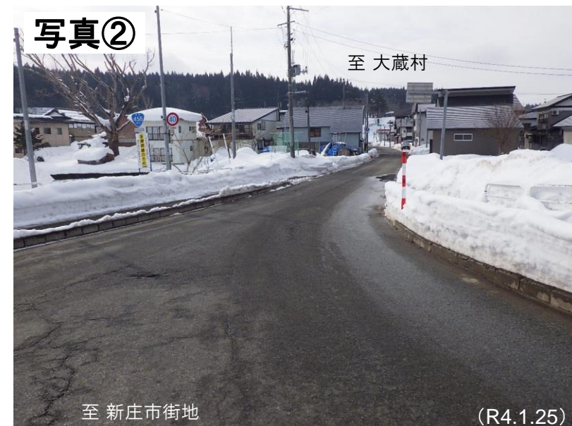
現場状況写真
