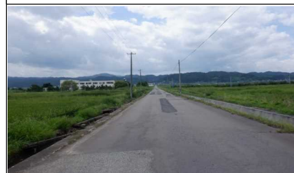
町道 北垣船町線 付近
