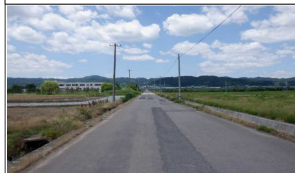
町道 北垣船町線 付近
