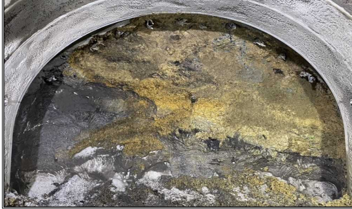
高屋トンネル(切羽写真)
