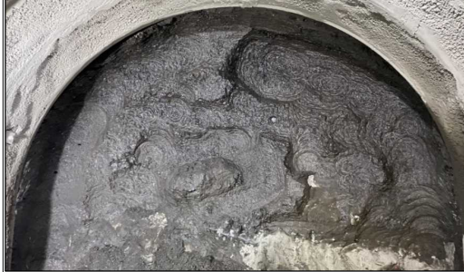
高屋トンネル(切羽写真)
