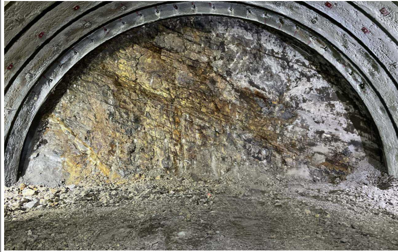
高屋トンネル(本坑切羽写真)
