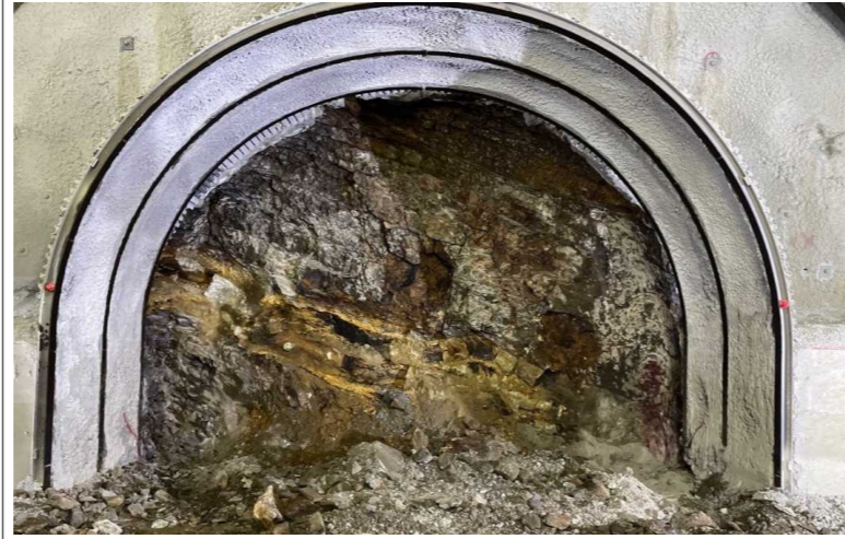
高屋トンネル(導坑切羽写真)
