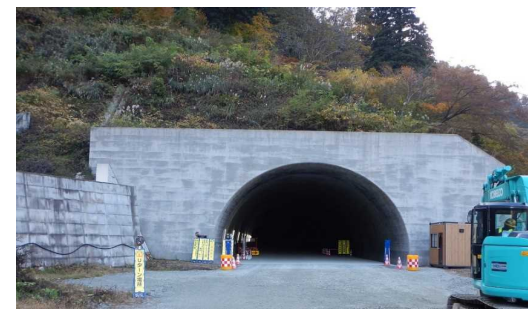
猪ノ鼻トンネル(新庄側)
