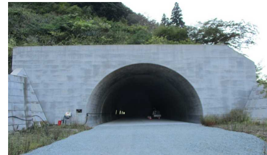
猪ノ鼻トンネル(新庄側)
