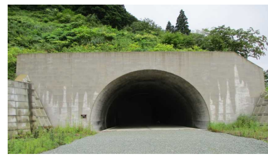
猪ノ鼻トンネル(新庄側)
