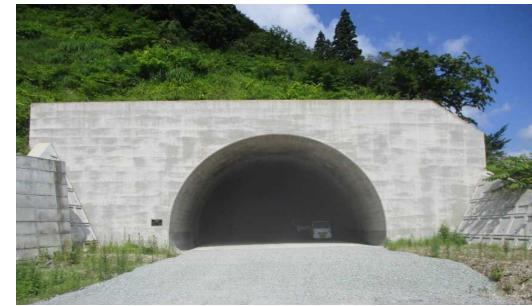
猪ノ鼻トンネル(新庄側)
