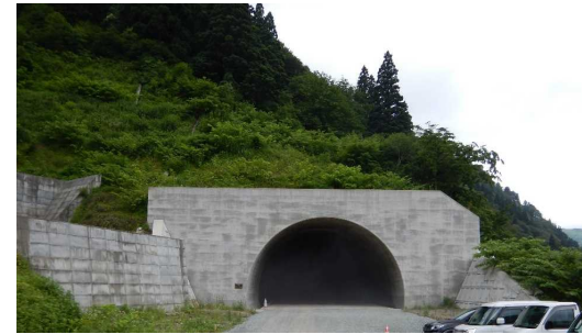
猪ノ鼻トンネル(新庄側)
