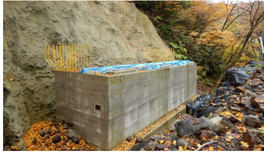
有田沢橋酒田側橋台
