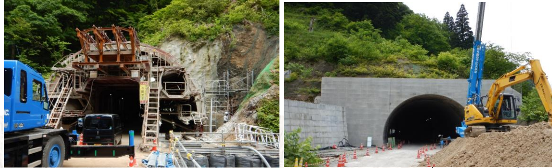
猪ノ鼻トンネル
