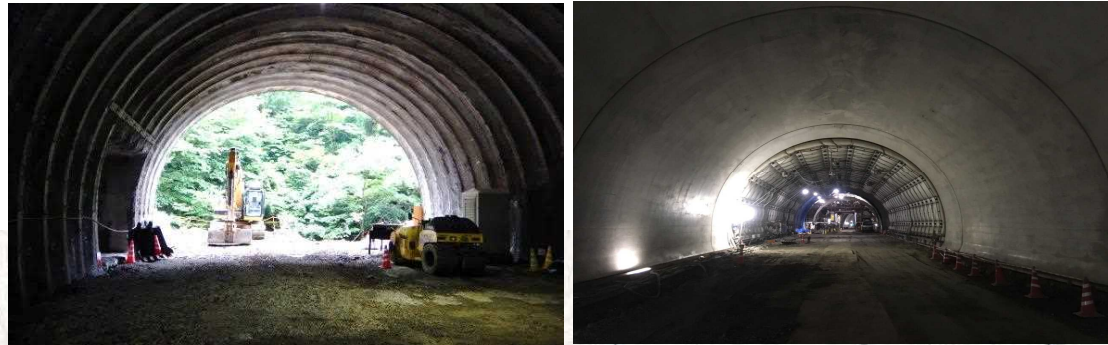
猪ノ鼻トンネル 掘削・覆工
