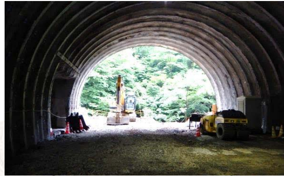
猪ノ鼻トンネル 掘削・覆工
