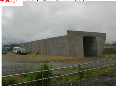
定点写真① 萩野地区(山形方向)
