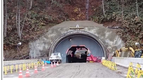
前波トンネル
