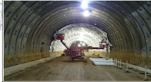
岩清水トンネル
