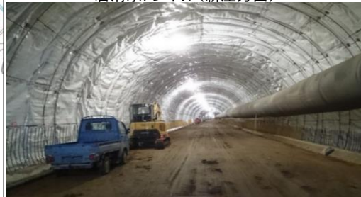
岩清水トンネル(新庄方面)
