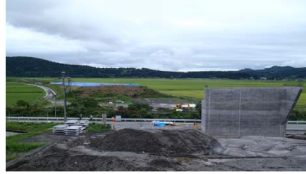
津谷跨線橋(新庄方面)
