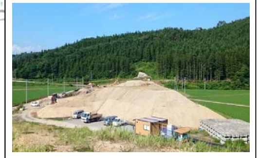
岩清水トンネル (鮭川から新庄方面)
