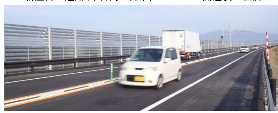
新庄古口道路(本合海~升形) L=2.4km 開通後の状況
