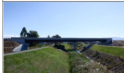
元宿川橋 付近
