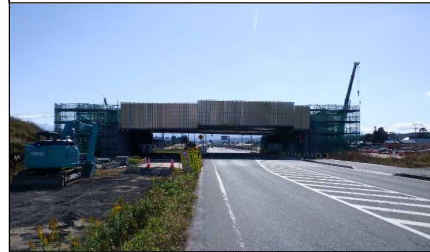
川西IC橋 付近
