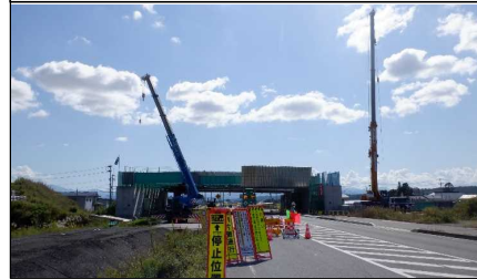
川西IC橋 付近
