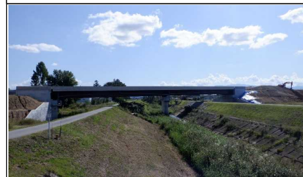
元宿川橋 付近
