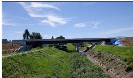
元宿川橋 付近
