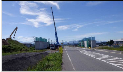
川西IC橋 付近
