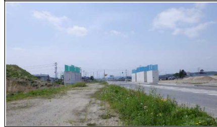
川西IC橋 付近
