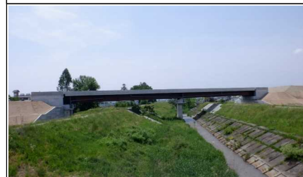
元宿川橋 付近
