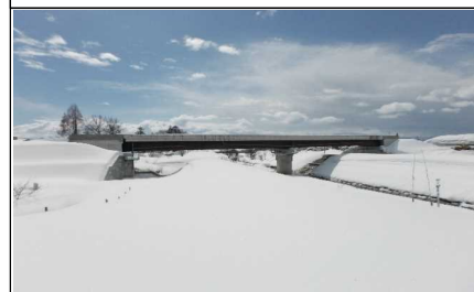
元宿川橋 付近
