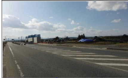
川西町西大塚 地内(小国方向)
