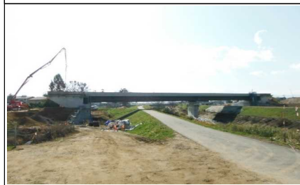
元宿川橋 付近
