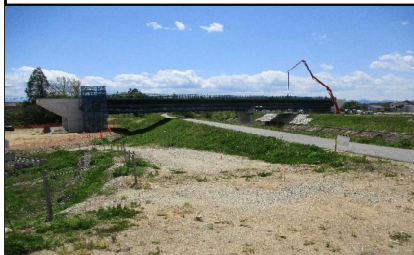
元宿川橋 付近
