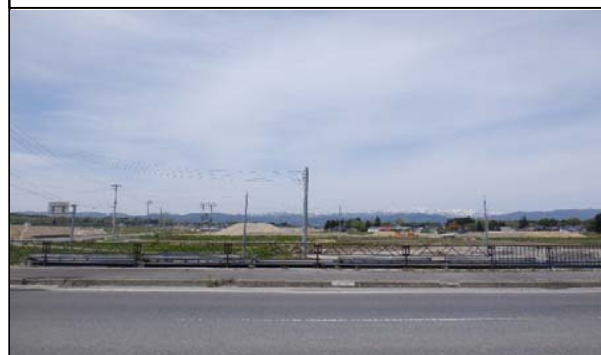
川西IC橋 付近
