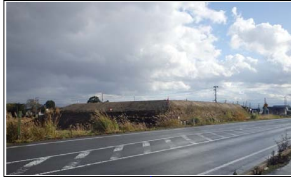
川西IC橋 付近
