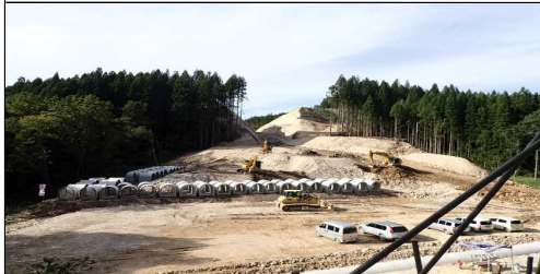
小国地区～岩井沢地区（現在施工箇所）
